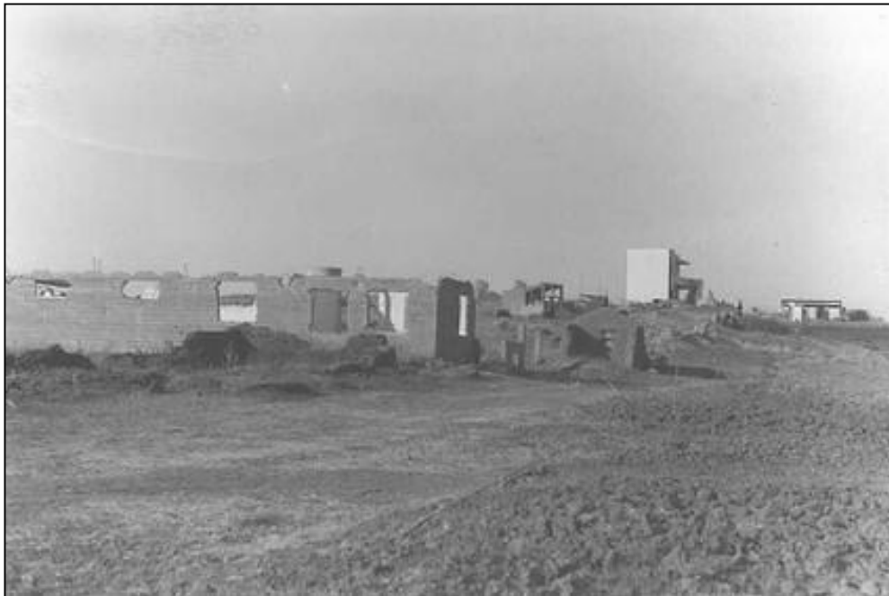
30 אפריל 1937, ימי המרד הערבי, המבנים נטושים ללא גגות. מבנה הבטון (בלבן) ברקע נטוש, והגדר סביב פרוצה. מקור: אוסף התצלומים זולטן קלוגר, D13-063
